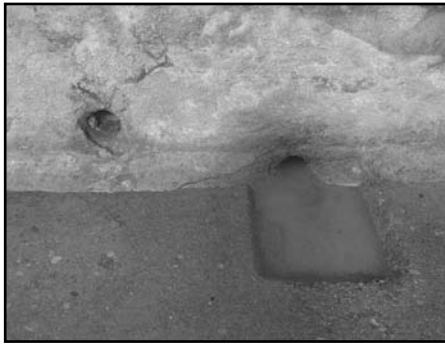
Resim 6: Su deposu tahliye çıkışı
