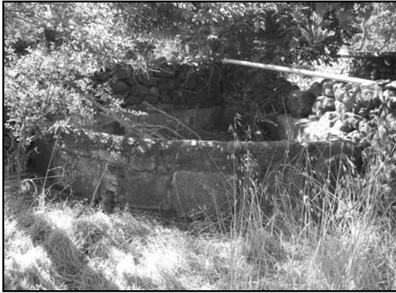
Resim 10: Sulama havuzundaki kemer blokları
